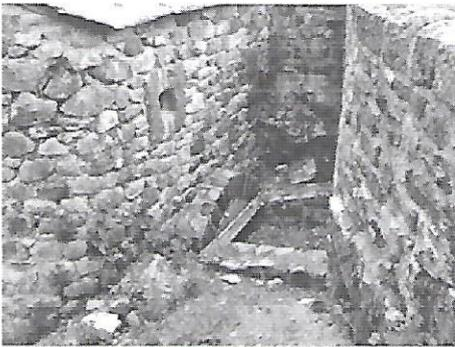
*L'alimentation en eau du moulin était prélevée en amont sur le Mars près de la « gone à bibi ». Elle est amenée en suivant la berge Nord grâce à un petit canal puis va se jeter sous l'arche de la façade Est du bâtiment.*
